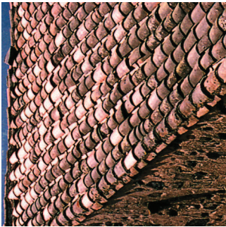
Pose de tuiles de récupération sur forme ondulée (il existe plusieurs procédés).
