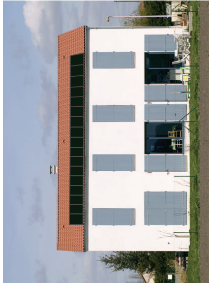
Les panneaux solaires seront implantés en partie basse du toit, et composeront dans la mesure du possible avec l'organisation de la façade.
