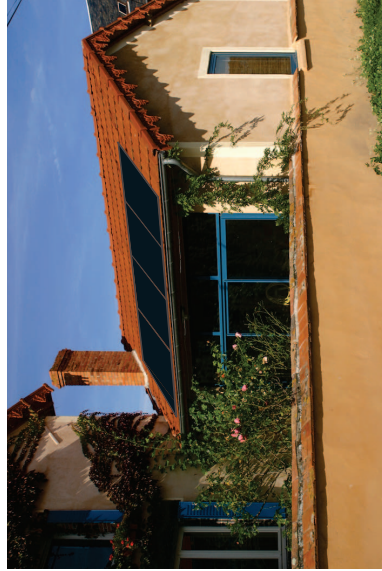
L'implantation des dispositifs solaires sur les annexes des bâtiments principaux est préférable, dans un souci de discrétion. Dans tous les cas, les éléments de structure seront de couleurs sombres afin d'éviter un effet de damier.
