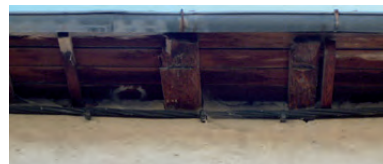
le débord ou «forget» sur chevrons est le plus représenté dans le fort
