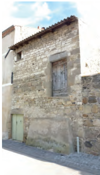
moellons de calcaire et joints «beurrés»: des maçonneries de très grande qualité
