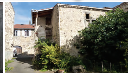
rue de l'Ormeau : une des plus caractéristiques et sans doute l'une des plus anciennes. Le poteau qui soutient l'estre est un tronc brut parcelles 360-1588
