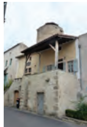
rue de la Barbarade une construction typique avec son escalier maçonné et sa charpente gracile parcelle 459
