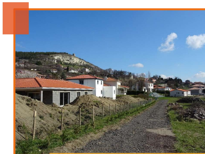
Constructions contemporaines créant une nouvelle lisière, franche et sans transition – La Roche Blanche // Even Conseil
