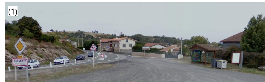
(1) Abribus situé au niveau de l'aire de repos sur la N89. Source: google
