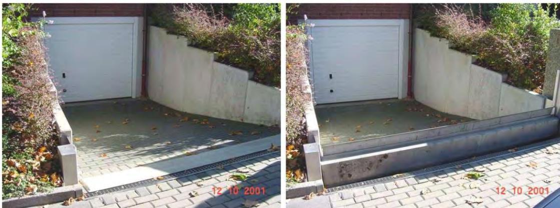
Des marches ou des revets peuvent être mis en œuvre devant les ouvertures afin de limiter les arrivées d'eau dans les habitations. Ceci peut nécessiter la mise en place de rampe d'accès.
