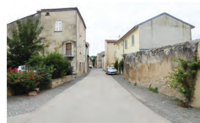
La rue du 8 mai et la rue de la Mairie sont les deux axes principaux de la Sauvetat qui ont fait l'objet d'une rénovation récente. La bande de roulement en enrobé grenaillé a été réduite et remplacée sur des rives par des petits pavés basaltiques. Ils mettent en valeur les placettes, les façades et le petit patrimoine tout en délimitant l'espace piétonnier.
