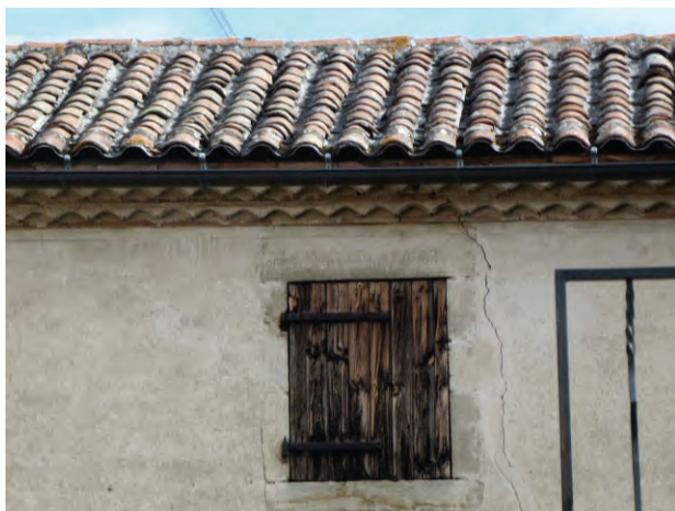
christine charbonnel, architecte - atelier Alpages, paysagiste
