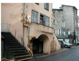
Maison vigneronne plus bourgeoise. Ici le support de l'estre repose sur un pilier en pierres (remarquer la présence d'arkose rouge). Il est possible que la partie bouchée par des pierres taillées corresponde à une ancienne échappe.
