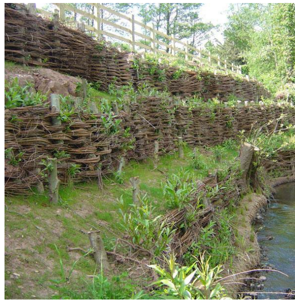
Terrasses en fascine tressée
