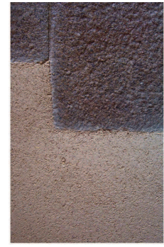
MORTIER CHAUX-CHANVRE Selon la nature des fibres utilisées, un enduit chaux-chanvre offre un aspect proche des enduits traditionnels tout en améliorant les qualités thermiques des maçonneries
