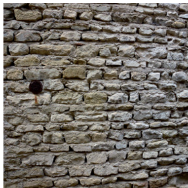
deux types de joints sur les loges : les joints «beurrés», formés par le mortier de pose, sont conservés en l'état ou soulignés par une ligne horizontale (joints dits «tirés au fer»)
