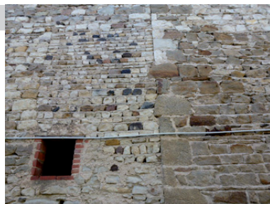
les chaînes d'angle et les appareillages différents des maçonneries permettent la lecture du parcellaire
