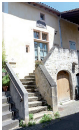
des façades qui témoignent de l'évolution du quartier
