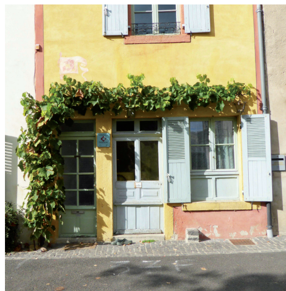
exemple de valorisation ponctuelle d'une façade par une vigne palissée
