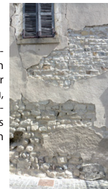
Restaurer les maçonneries de moellons
