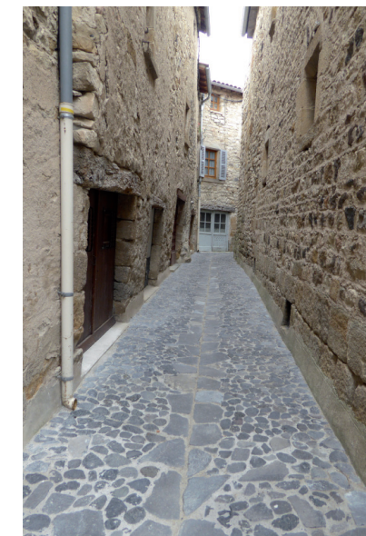
calade récemment réalisée dans le fort
