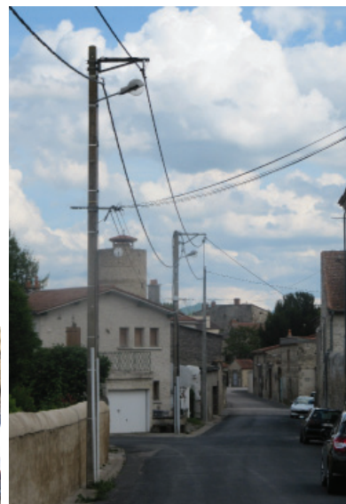
La rue du 8 mai avant les travaux de rénovation qui ont permis d'enterrer les réseaux aériens.
