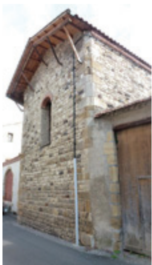
rue Dodel : perpendiculaire à la rue un grand bâtiment particulièrement soigné parcelle 1523
