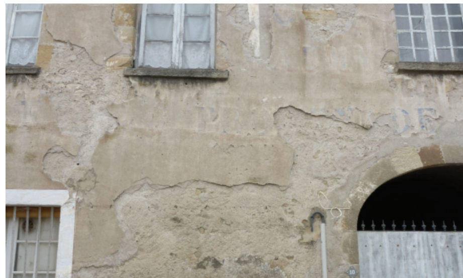
la dégradation de l'enduit dévoile les techniques de mise en oeuvre (couche d'accrochage, «gobetis», enduit de finition et décor en badigeon (enseigne))
