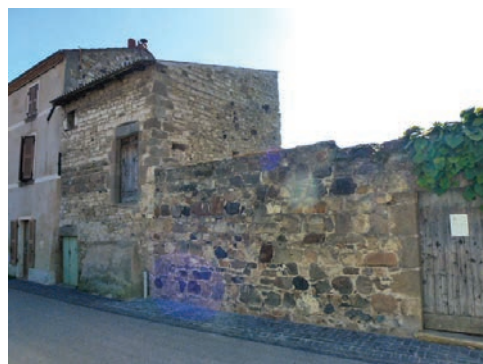
dépendance agricole et mur de clôture : une qualité remarquable de la maçonnerie et une architecture parfaitement sauvegardée
