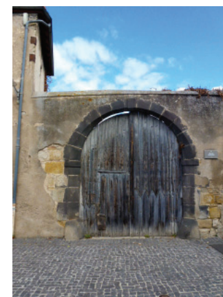
portes cochères sous linteaux bois ou arcs
