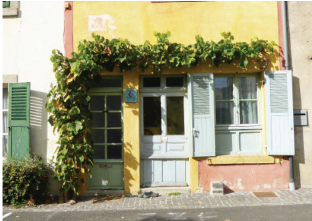
La présence de vigne palissée sur les façades exposées au sud est récurrente dans le centre du village
