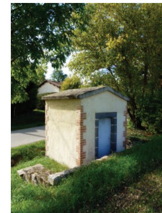
Répartiteur route de Plauzat
