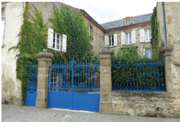
Une des rares cours visibles depuis la voie publique (rue du 8 mai)
