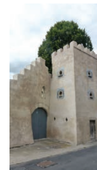
vestiges de la chapelle (parcelle 1642)
