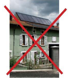
Exemple d'une installation en contradiction complète avec l'architecture traditionnelle
