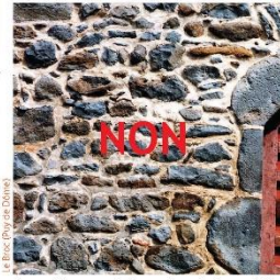
Lorsqu'ils pourront être envisagés, les enduits laissant apparaître la maçonnerie seront obligatoirement traités avec des joints beurrés (pierre et enduits au même nu) et non avec des joints en creux détournant les pierres.
