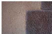
MORTIER CHAUX-CHANVRE Selon la nature des fibres utilisées, un enduit chaux-chanvre offre un aspect proche des enduits traditionnels tout en améliorant les qualités thermiques des maçonneries
