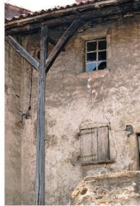
Contrairement à une idée reçue, l'architecture rurale est enduite ou destinée à l'être, du moins pour les bâtiments d'habitation. Si la qualité de la pierre le permet, on peut, au cas par cas, conserver des maçonneries simplement rejointoyées (murs pignons, par exemple). C'est la dégradation des enduits qui, en révélant la maçonnerie a pu laisser croire qu'il s'agissait là d'un état "initial" souhaitable à révéler. L'enduit traditionnel, à base de chaux, arbore une teinte plus claire que la pierre utilisée. Il était souvent recouvert d'un badigeon.
