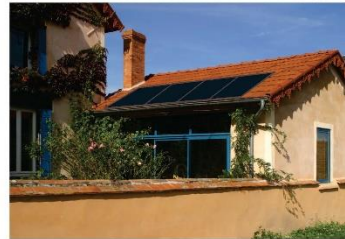
L'implantation des dispositifs solaires sur les annexes des bâtiments principaux est préférable, dans un souci de discrétion. Dans tous les cas, les éléments de structure seront de couleurs sombres afin d'éviter un effet de damier.
