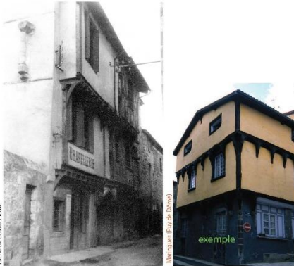
Le dégagement des pans de bois ne devrait intervenir que si les structures cachées présentent un intérêt esthétique, ce qui est rarement le cas. Seules les sablières et les aisseliers les soutenant sont destinés à rester vus (ci-dessus une restauration récente dans le Puy de Dôme).
