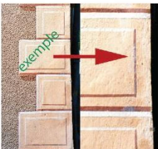
F. Dans ce cas, la solution consiste à enduire le pari de moellons, mais pas les parties formant saillie, sans rien retrancher ni ajouter.
