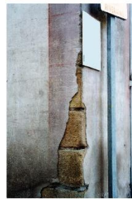
La dégradation de ce badigeon de la seconde moitié du XIXe siècle nous montre que les pierres d'angles en ardoise étaient destinées à rester enduites.
