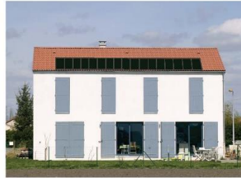
Les panneaux solaires seront implantés en partie basse du toit, et composeront dans la mesure du possible avec l'organisation de la façade.
