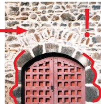
Ce type d'aspect déstructure complètement les dispositions architecturales d'un bâtiment.
