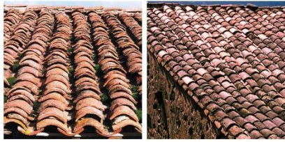
Pose de tuiles de récupération sur forme ondulée (il existe plusieurs procédés).
