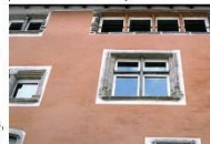
Badigeon sur enduit, avec débourrage des ouvertures. La façade est plus vivante et présente une unité dans sa diversité.
