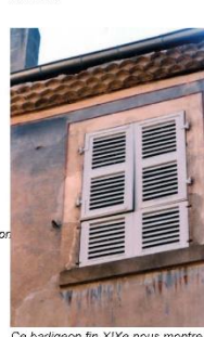
Ce badigeon fin XIXe siècle nous montre qu'une architecture même simple doit faire l'objet d'un soin, comme le débourrage d'un faux encadrement, qui nous permet de comprendre la composition de façade.
