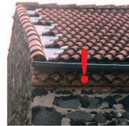
La tuile mécanique (même à onde) est très souvent synonyme de zincuerie, pour contraindre les irrégularités géométriques
