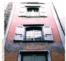
Un badigeon décoré récent (1955) sur un immeuble ancien plutôt original. La restauration, qui est ici créative, a été datée ce qui inscrit l'opération dans une nouvelle dimension historique.
