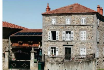
L'implantation des dispositifs solaires sur les annexes des bâtiments principaux est préférable, dans un souci de discrétion. Dans tous les cas, les éléments de structure seront de couleurs sombres afin d'éviter un effet de damier.
