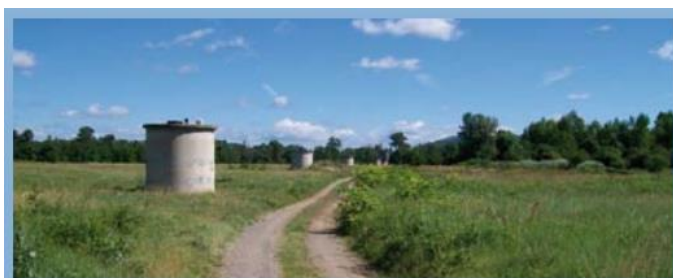
▲ Puits de captage de l'Allier
