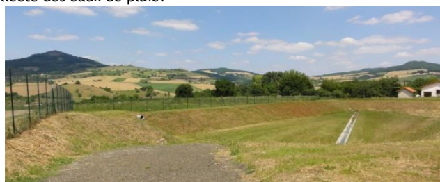
Bassin d'orage au nord de la Ville de Vic. à hauteur de Champ Parouti.
