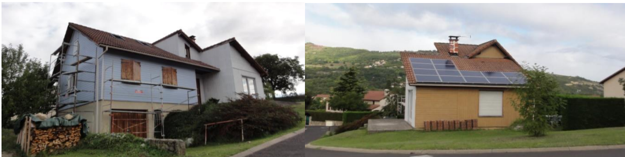
Longues. Même sur les constructions récentes (pavillon postérieur à 1950), des rénovations thermiques sont entreprises.
